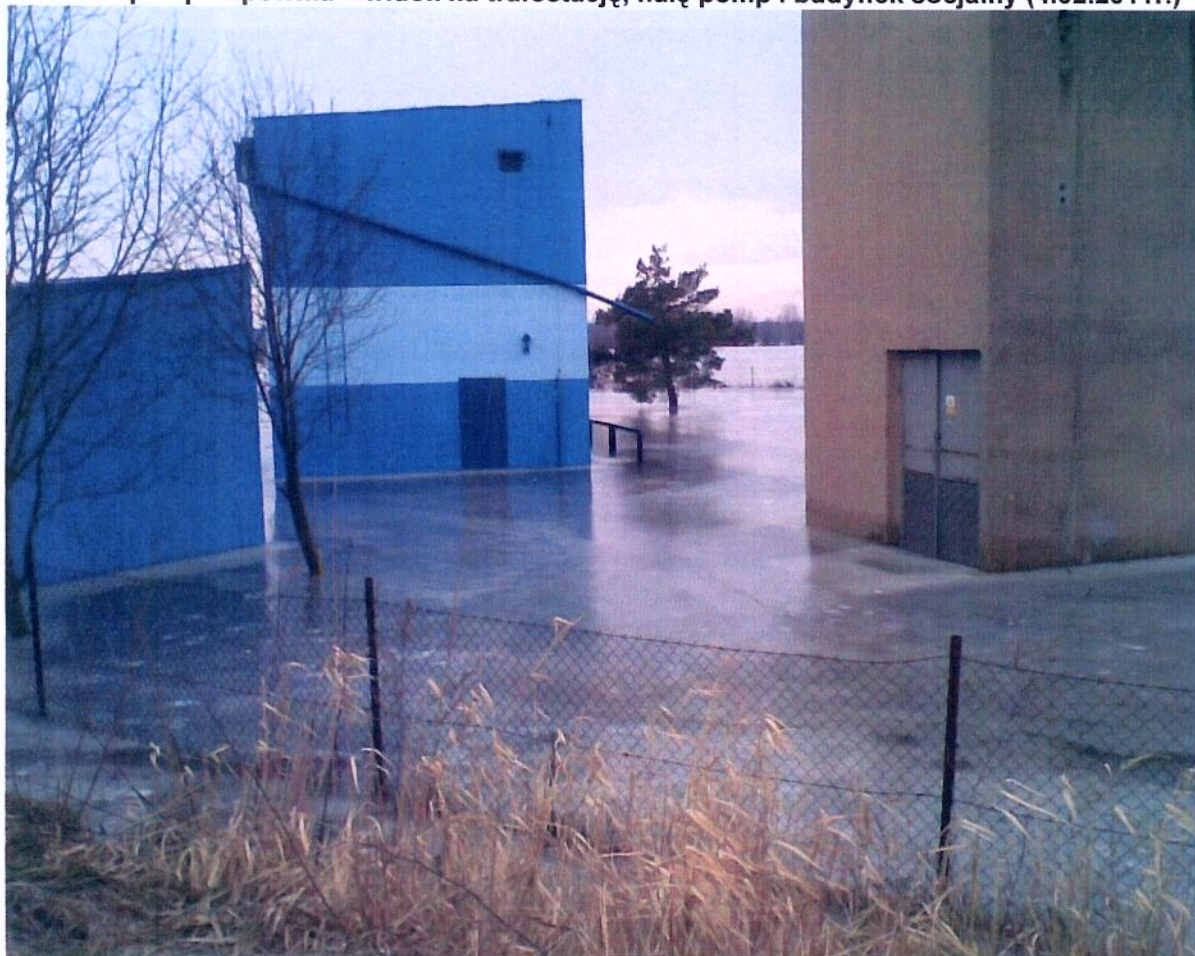
1. Zalana przepompownia – widok na trafostację, halę pomp i budynek socjalny (4.02.2011r.)
